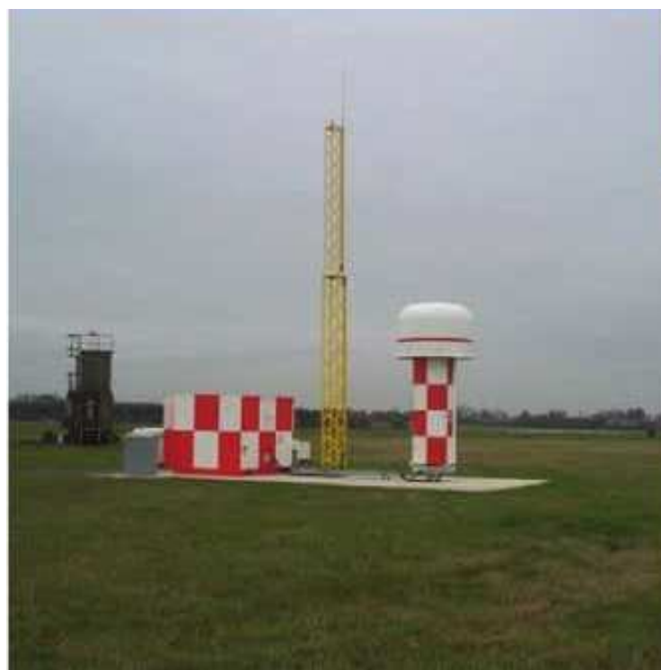
Figure 17.4 PAR installation at RAF Marham
